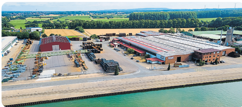
Die Produktionsstätte Teuto Baustahlmatten in Bad Essen/Wehrendorf mit einem Gleisanschluss und einem Zugang an den Mittellandkanal.
